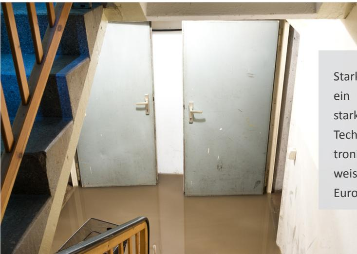
Starkregen führte in kürzester Zeit dazu, dass ein an ein Firmengelände angrenzender Bach unerwartet stark über die Ufer trat. Das Wasser drang in den Technikraum der Firma ein und beschädigte die elektronischen Steuereinheiten der Aufzüge und – teilweise – der Brandmeldeanlage. Schadenshöhe: 7.500 Euro.
